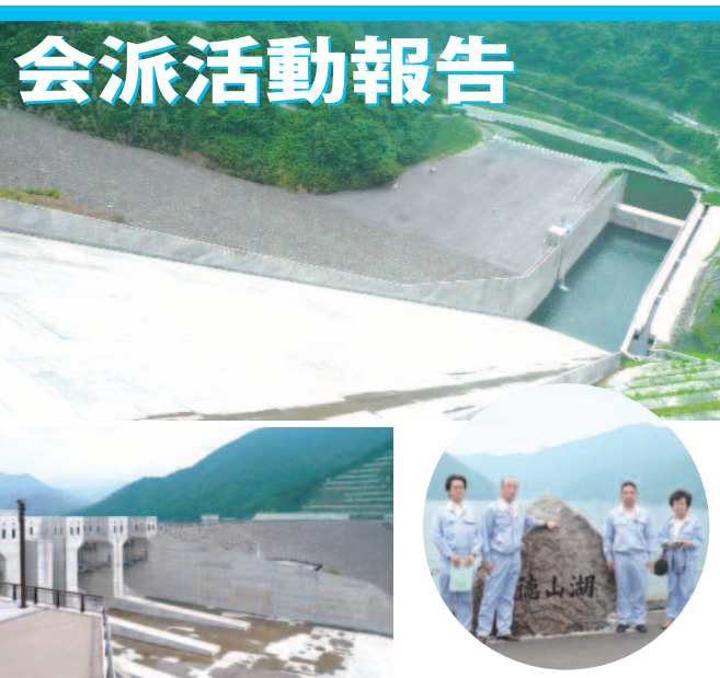
日本一の大きさを誇る巨大ダム「徳山ダム」を視察(5月28日・岐阜県 揖斐川上流)
