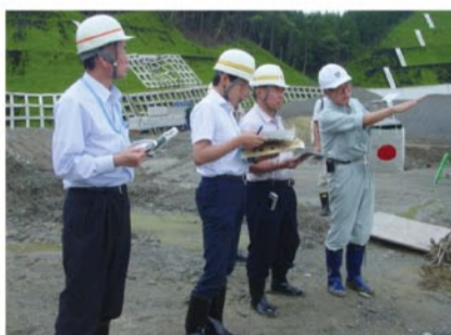
●7月12日クリーンセンター滋賀建設現場にて
